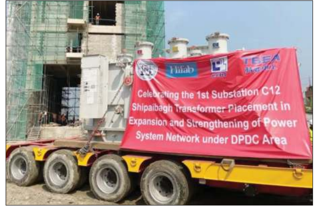
উচ্চক্ষমতা সম্পন্ন পাওয়ার ট্রান্সফরমার স্থাপনের কাজ চলছে
